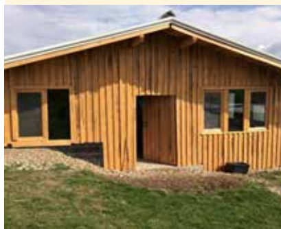
Neuer Anbau für den Ziegenstall
