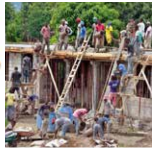
Arbeiten an der Dorfgrund- schule in Torbeck. Foto: SBH
